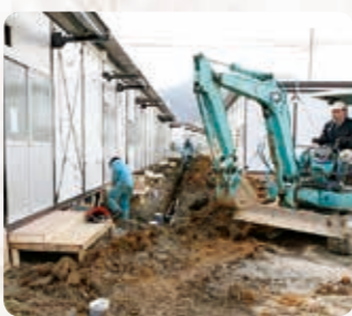
迅速な用地協力により県内第1号となる仮設住宅が完成
