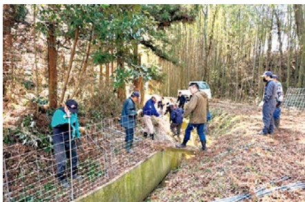
▲新たに侵入防止柵を設置（貝田地区）
