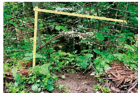
▲侵入防止柵破損によるイノシシ通路
