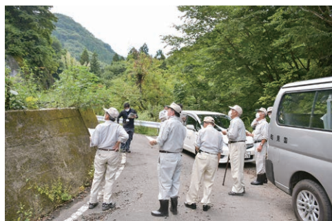
災害復旧工事を行った林道貝田線の現場を確認
