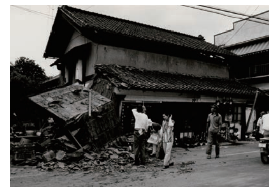
宮城県沖地震で倒壊した家屋
