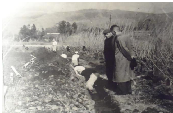
昭和32年 山崎簡易水道布設工事風景
