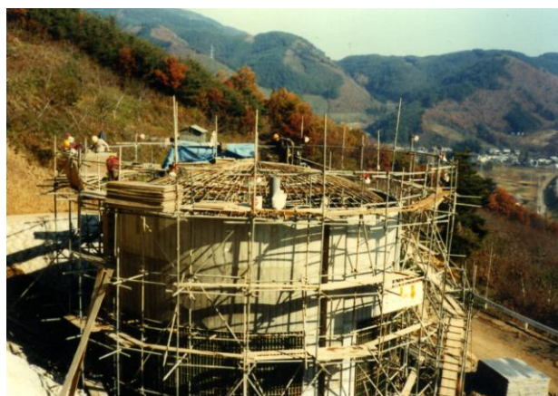
昭和55年 新田山配水池建設工事風景
