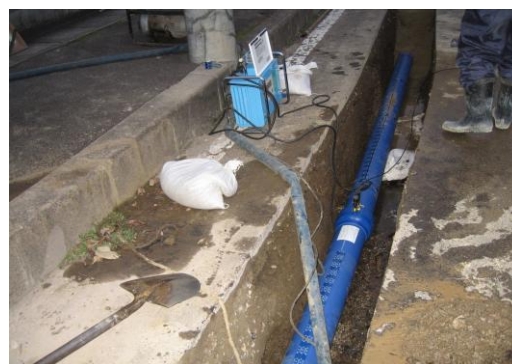
耐震管の布設
