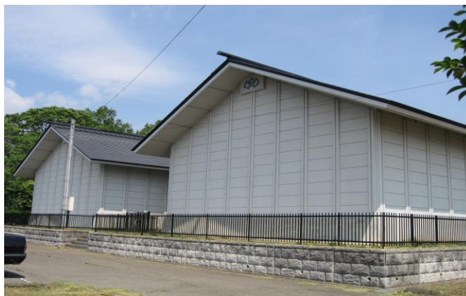
源宗山配水池
