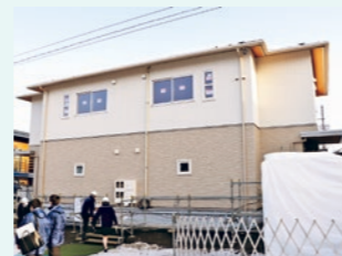
建設中の板橋南子育て住宅
