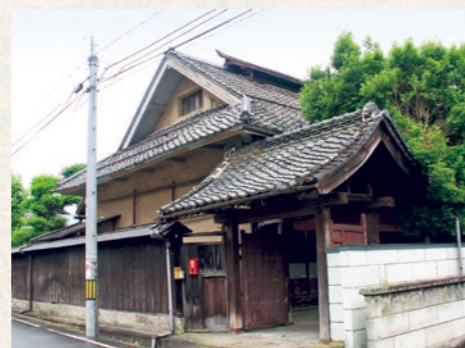
「松田家住宅」道側から
