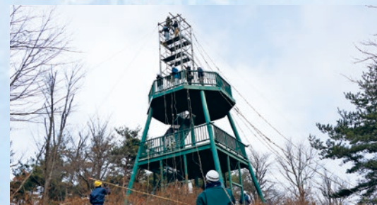
町建設業協会と管工事組合の皆さんによる設置作業
