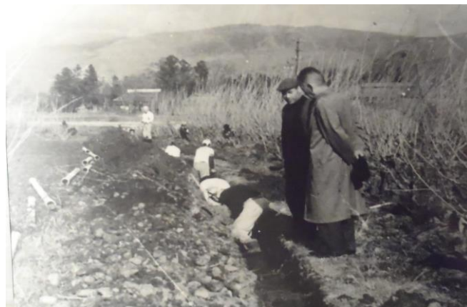
昭和32年 山崎簡易水道布設工事風景
