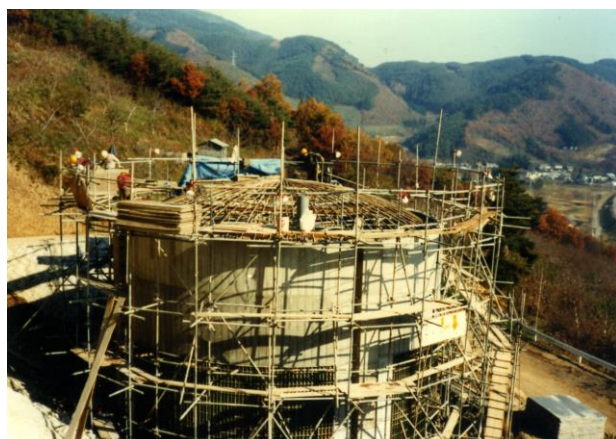
昭和55年 新田山配水池建設工事風景
