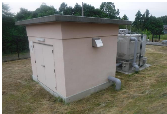
泉田ポンプ場（平成28年3月完成）
