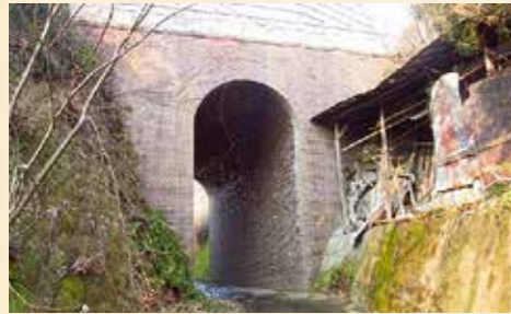
④貝田姥神沢旧鉄道レンガ橋
