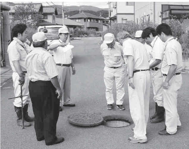
下水道の被災状況を調査(国見ニュータウン内)
