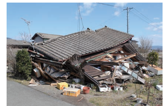
東日本大震災で倒壊した家屋
