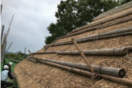
写真 7-9 旧佐藤家住宅茅葺替え工事
