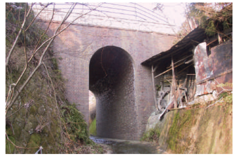
写真 3-10 貝田姥神沢旧鉄道レンガ橋
