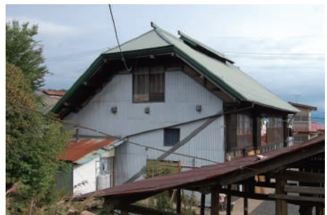
写真 3-20 あづま造りの民家
