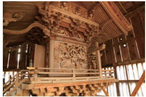
写真 3-5 沼田神社本殿彫刻
