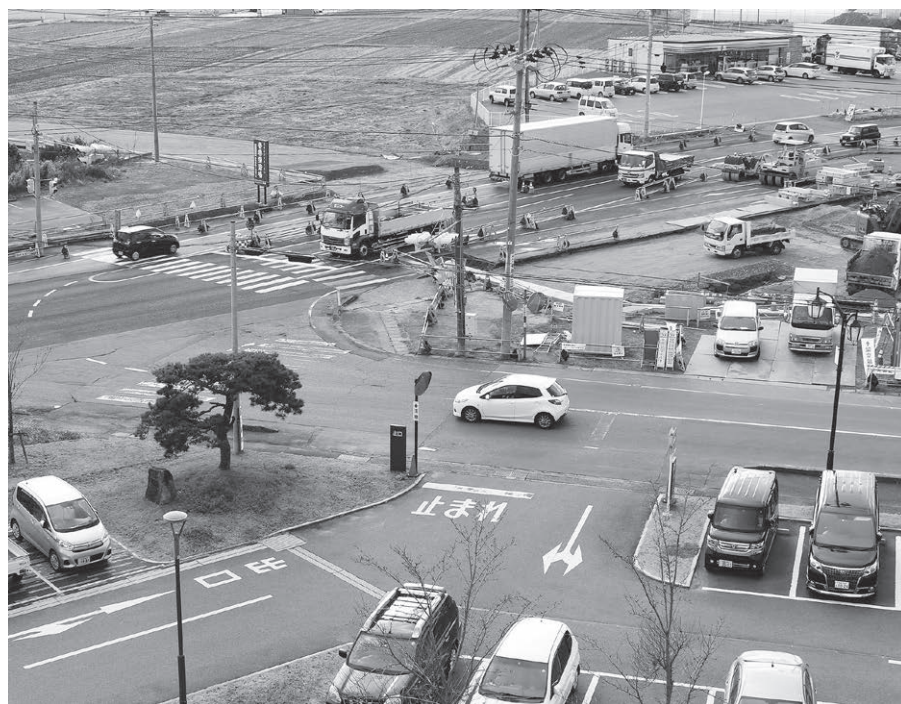
急ピッチで工事が進められている役場前交差点
