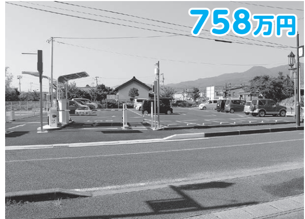
藤田駅前の駐車場整備工事を行いました。
