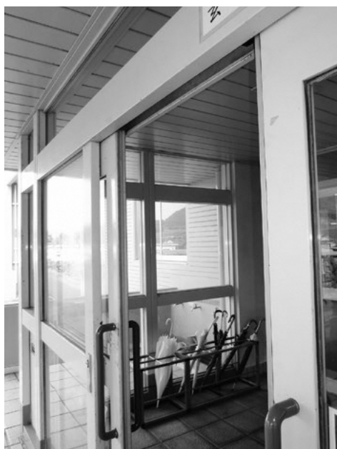
改修を終えた昇降口の扉
