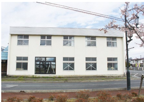
第一期改修工事が完了した駅前倉庫
