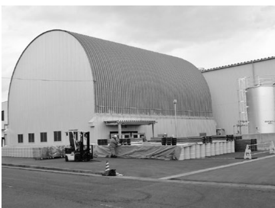
着々と処理されていく汚泥 (県北浄化センター)
