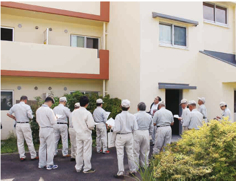
滝山団地の改修された外壁を確認しました
