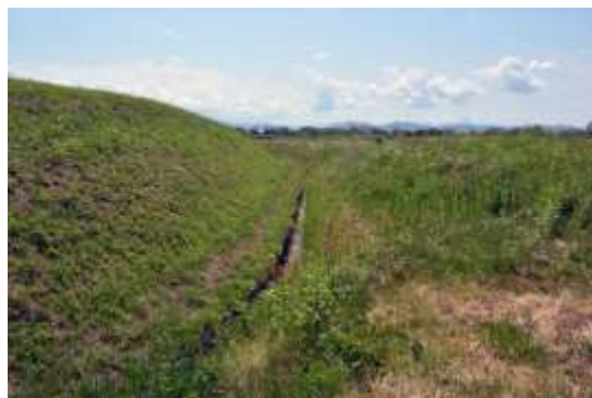
防塁西水路を挟んだ残土盛土
