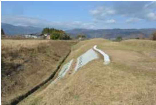
中央部西側法面 平成 28 年 10 月修復作業
