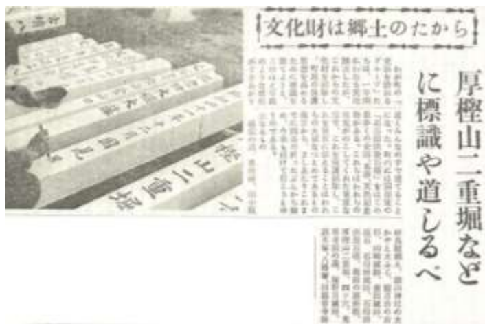
■町文化財標識の設置『国見町公民館報』昭和41年(1966)
