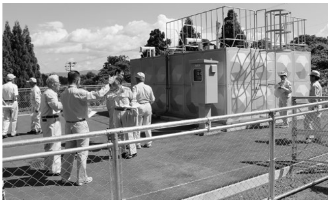
泉田赤坂配水池施設で説明を受ける議員
