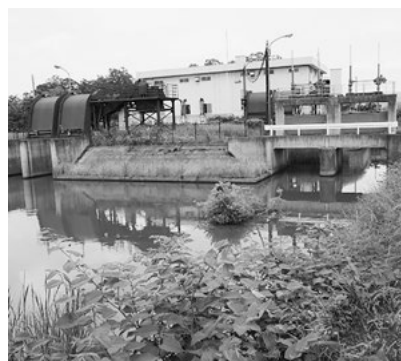
普段は穏やかな湛水防除施設
