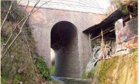
④ 貝田姥神沢旧鉄道レンガ橋 牛沢川(貝田付近では「姥神沢」とも)に架かる貝田姥神沢旧鉄道レンガ橋は、明治20年(1887)の黒磯-塩釜間開業当初の旧鉄道橋で、大正9年(1920)まで使用されていました。橋の構造はレンガ積アーチ構造で、町並みに近接して鉄道が往来していた当時の様子を伝えています。
