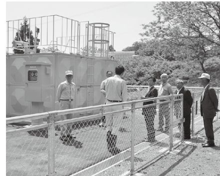
新しくできた赤坂配水池を視察
