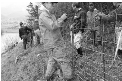
地域で協力し設置した柵も完全な侵入防止はできない
