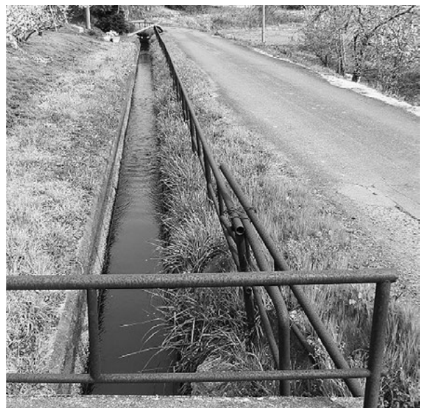
西根堰と隣接の町道(西大枝地内)
