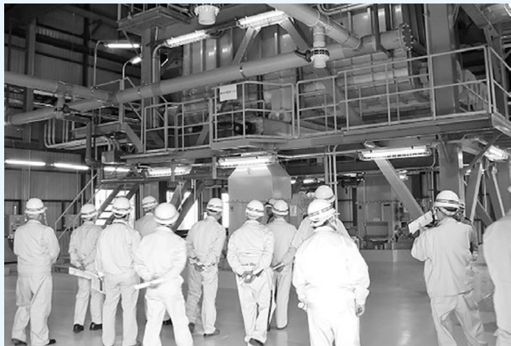
汚泥乾燥施設の内部を調査(県北浄化センター)
