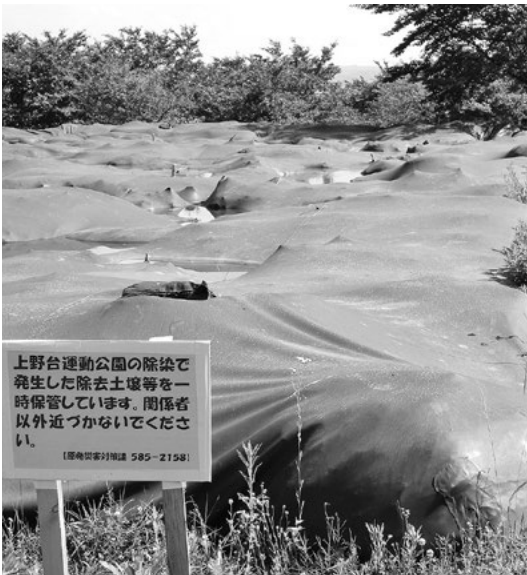
野積みそのままになっている除去土壌
