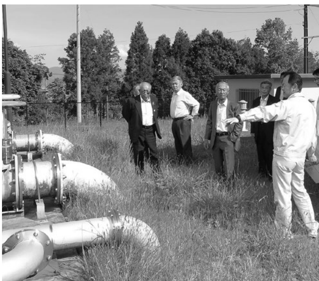
受水施設を確認
