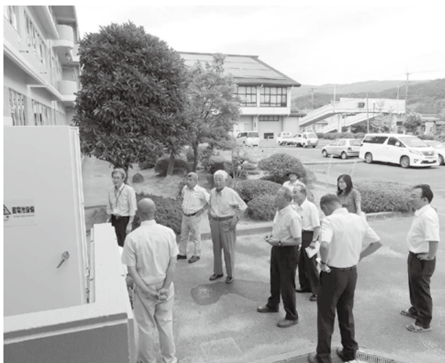
②非常時の電力供給に利用できる蓄電池
