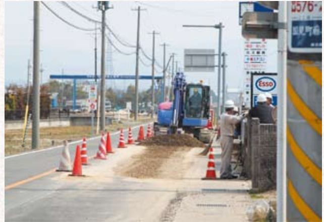
資材不足の懸念の中、懸命の復旧作業が続いた。
