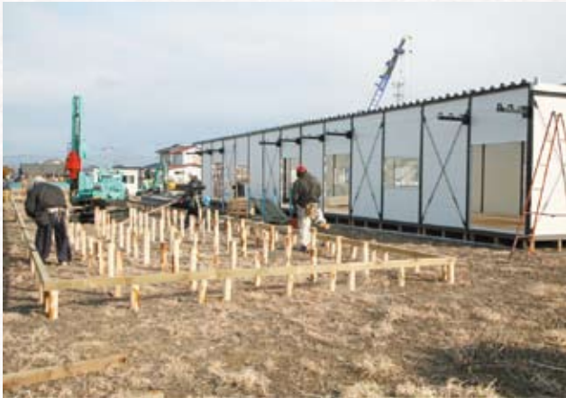
県内でもいち早く進められた仮設住宅の建設。
