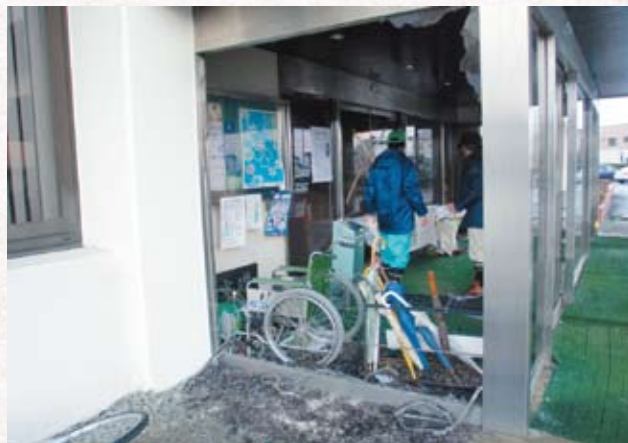
庁舎玄関風除室。丈夫なガラスは、激しい揺れで粉々になっていた。
