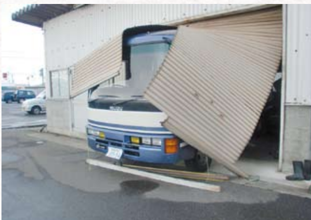
庁舎西側車庫に格納されていたマイクロバスは、揺れによりシャッターを突き破っていた。
