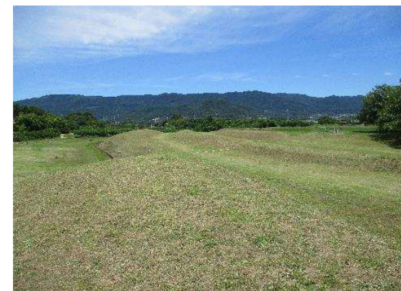
阿津賀志山防塁下二重堀地区の管理状況
