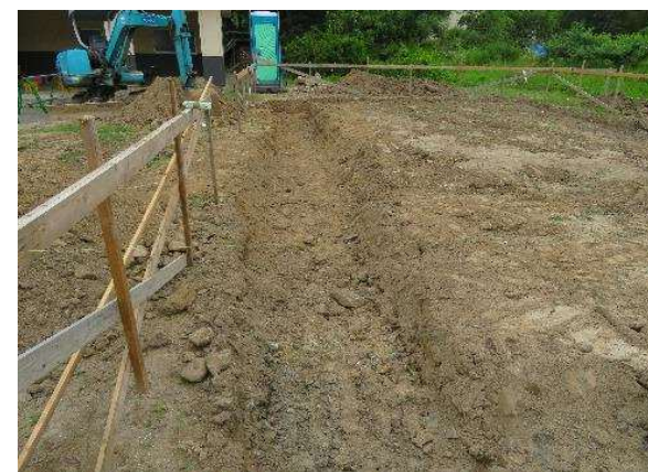
工事立会(中屋敷跡)
