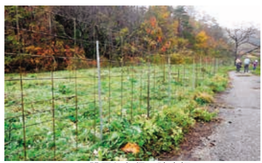
設置した侵入防止柵
