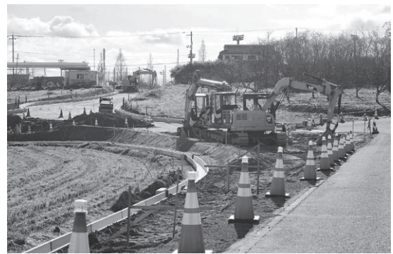
工事中の町道(石母田地区)
