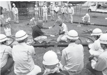
圏域市町村による水道応急合同訓練
