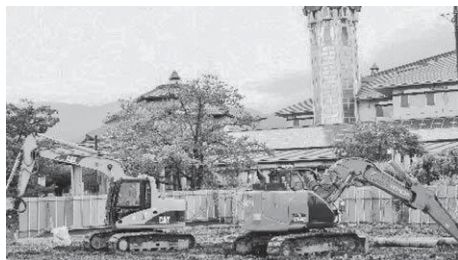
解体工事中の体育館
