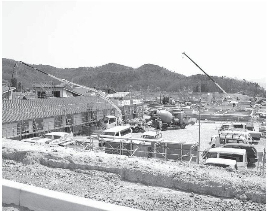
7月完成に向け工事の進む国見の里
