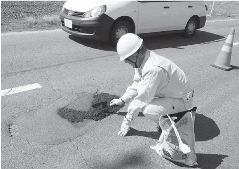
道路監視員による道路修繕(徳江字仏供田地内)
